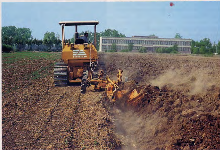
Foto 1 - Scasso del terreno alla profondità di 70 cm
