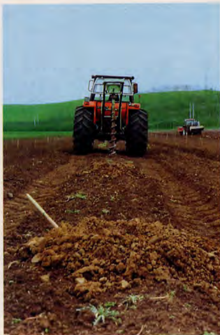
Foto 4 - Scavo delle buche con trivella alla profondità di 1,5 m
