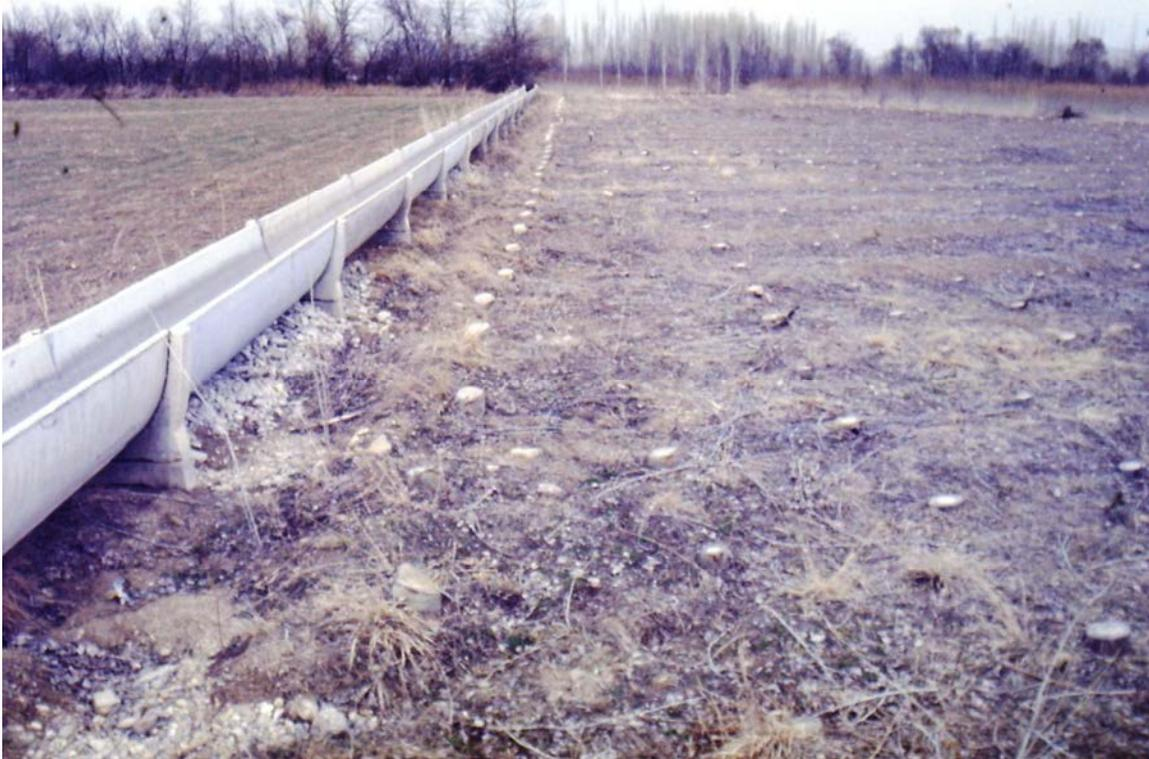
Canaletta in cemento sopraelevata per portare l'acqua di irrigazione.
